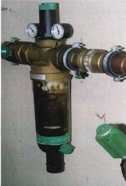
Bild 14: Verschmutzter Wasserfilter
